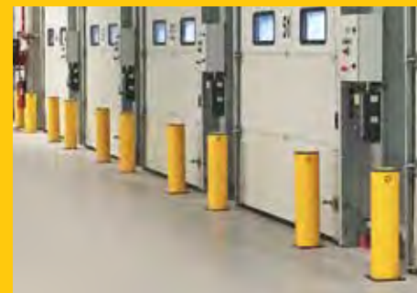
Poller zum Schutz von Tür- und Rolltorzargen in einem neu errichteten Lager- und Distributionszentrum.
