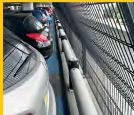
iFlex Parkplatzbarriere als Absturzsicherung auf einem Parkdeck.
