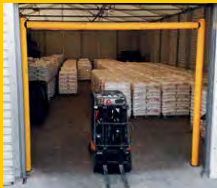
Höhenbegrenzer als Orientierungshilfe und zum physischen Schutz der Fahrzeugführer.
