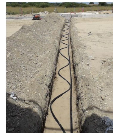
13:00 – 16:00 Montaža cjevovoda, pripremljenog u točnim dimenzijama
