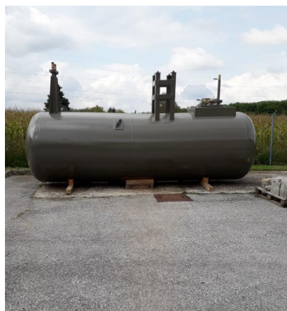
9:00 Spremnik dolazi na gradilište
