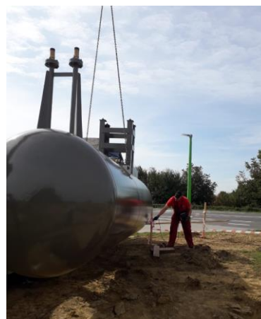
10:00 Popravak izolacije, montaža spremnika na temelj
