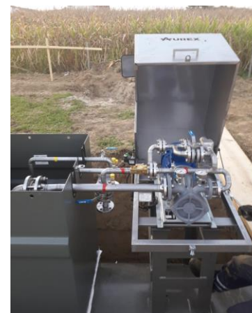
11:30 Montaža pumpnog sklopa i šahte, pripremljenog u radioni
