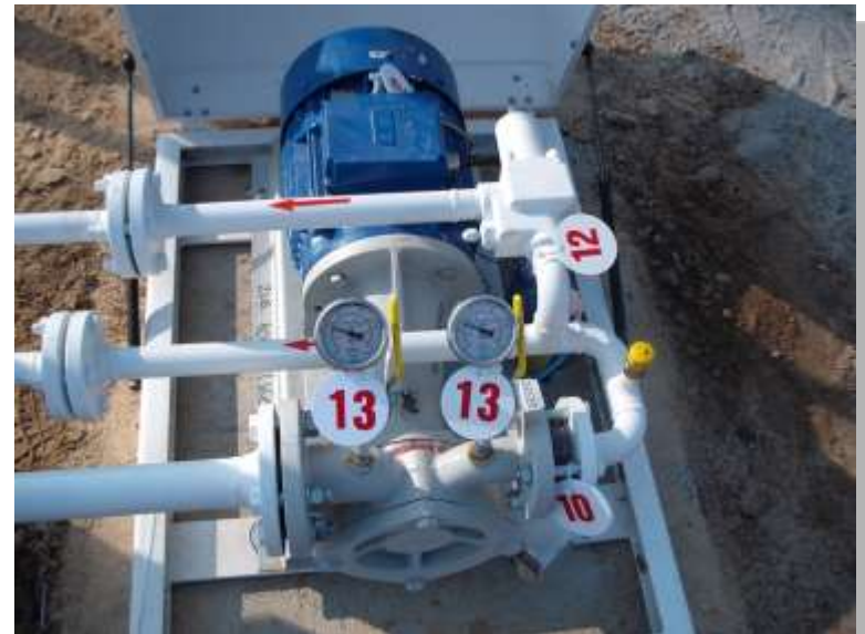
Aurex LPG pump unit DLD150 / 5,5 kW - Kornik.
