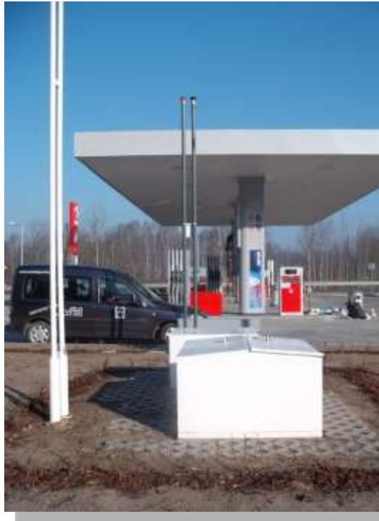
Aurex LPG pump unit DLD150 / 5,5 kW - Kornik.
