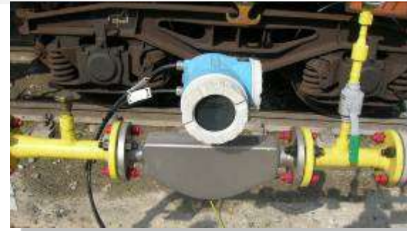
Vapor phase mass meter
